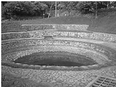
第21図 太田金山城復元工事
