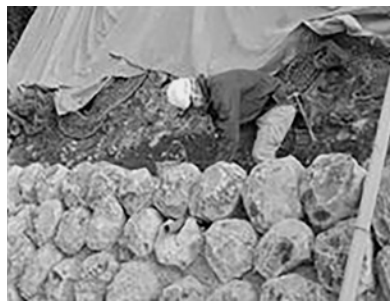
第27図 石積み作業
