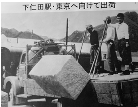
第16図 下仁田駅より東京へ向けて出荷 鉄製の棒状道具・かなてこ（パール）を使っている。8人分の力を出すという意味で、「テコ8人」という言葉がある。 写真は当時の石材積みだし風景。
